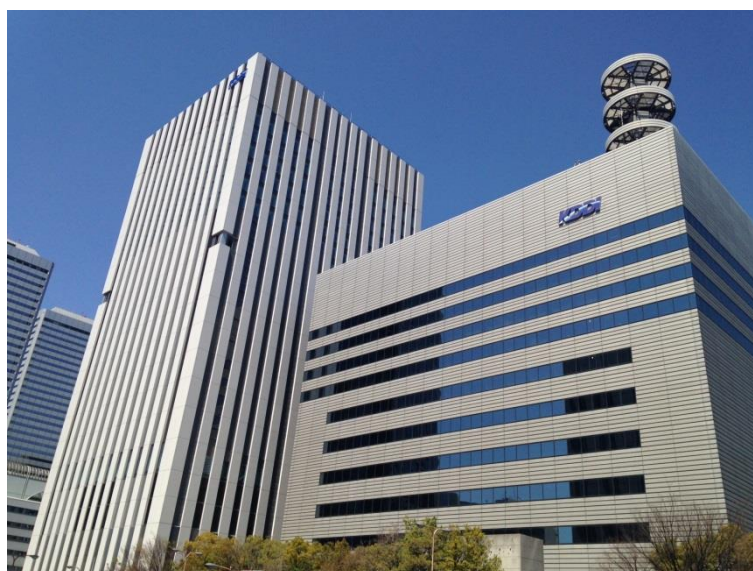
&lt;「大阪ローン推進室」が入居する KDDI 大阪第2ビル（写真左）&gt;
